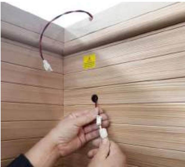
(9) Saunalichtkabel wie oben anschließen.
