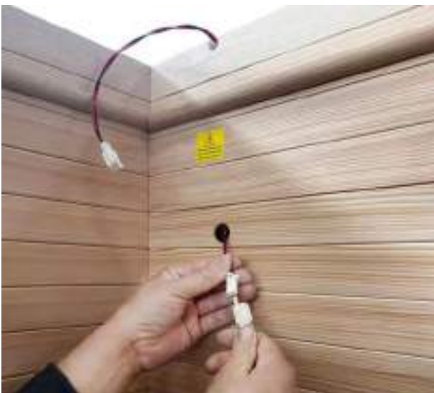
(9) Conectați cablul de lumină pentru saună ca mai sus.
