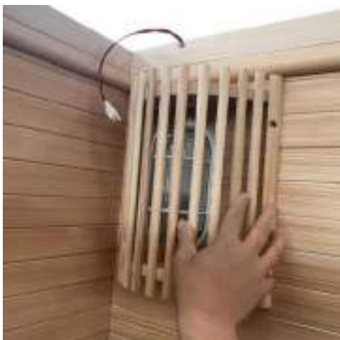
(12) Sestavte dřevěný kryt pro saunové světlo (šrouby 3x25mm 8 kusů)
