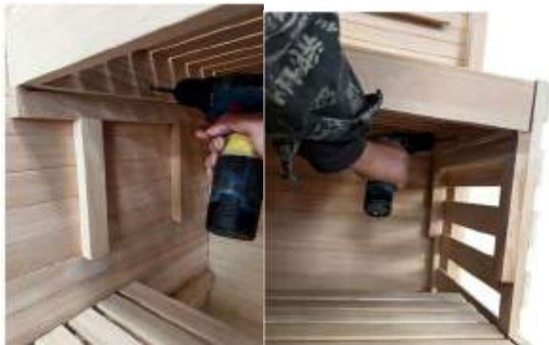
(8) Folosiți șuruburi pentru a fixa părțile stângă și dreaptă sub bancă (vezi fotografiile) (șuruburi 4x50mm)
