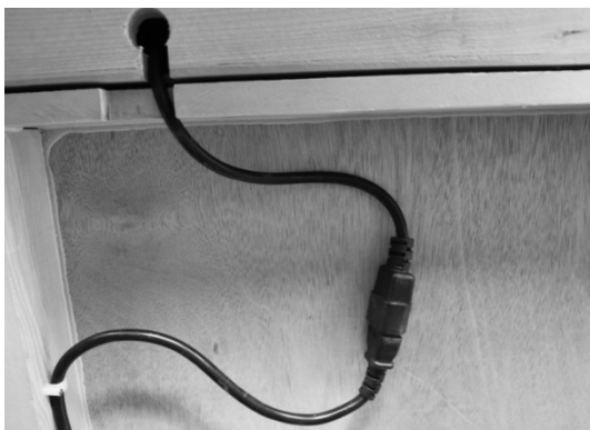
(1) spojite konektore kabela grijača, pazite da kablovi nisu uhvaćeni između stropnog i drugih panela
